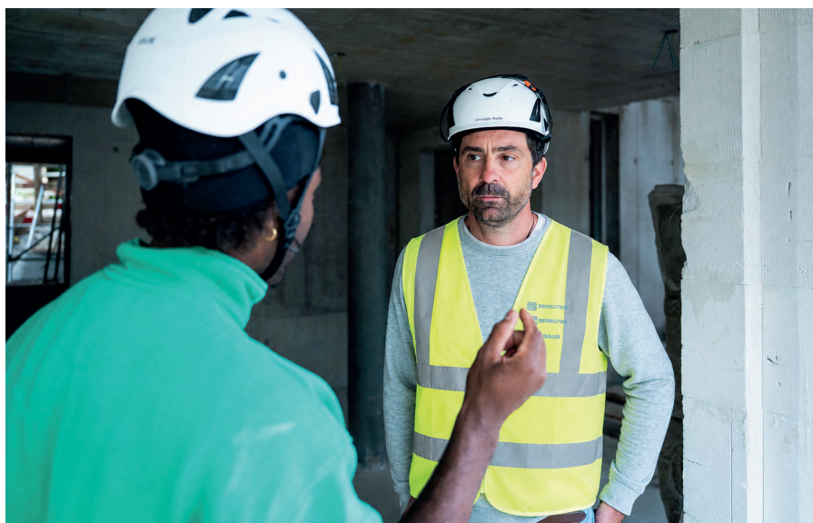
Bauführer Christoph Riedel (rechts) im Austausch mit Polier Javier Medina Jay.
